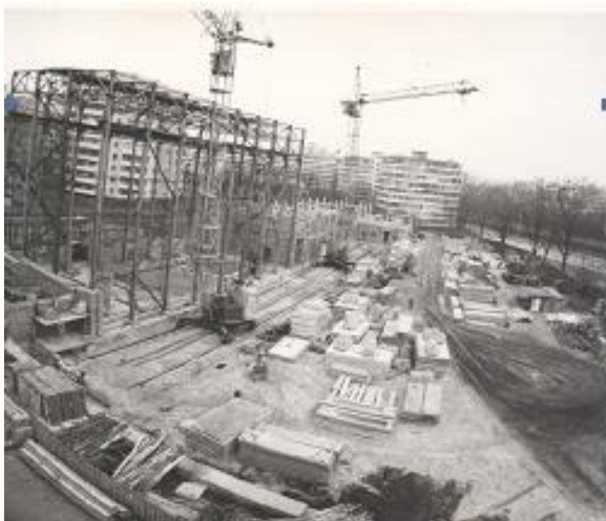
Будівництво корпусу МНДІ ПМ «Ритм». 1990р
